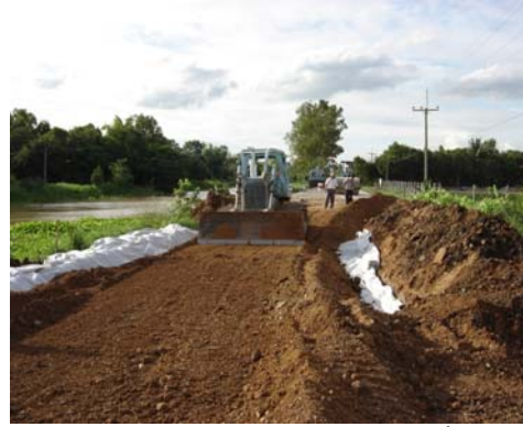
แก้ไขโดยการเสริมชุดดินส่วนเสียหายออก แล้วเสริมที่ฐานคันดินด้วยแผ่นใยสังเคราะห์ชนิดรับแรงดึงสูง : ชั้น โพลีฟิลท์ Rock PEC 150
