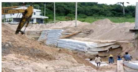
ระบบการหล่อเสริมกำลังดินเป็นชั้น ๆ ด้วยวัสดุแผ่นใยสังเคราะห์ชนิดรับแรงดึงสูง แต่ การยึดตัวที่ต่ำ ของโพลีเอทิลีน ร็อก ฟีโอซี
