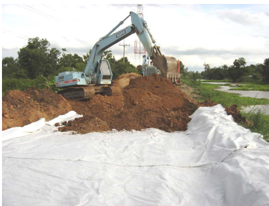
ระหว่างการก่อสร้างติดตั้งแผ่นใยสังเคราะห์ที่ฐาน และการบดอัดดิน
