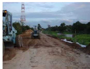
ระหว่างการก่อสร้างติดตั้งแผ่นใยสังเคราะห์ที่ฐาน และการบดอัดดิน
