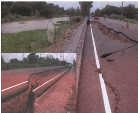
สภาพความเสียหายของคันถนนริมคลอง ๘ ปทุมธานี
