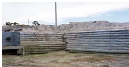
ระบบการหล่อเสริมกำลังดินเป็นชั้น ๆ ด้วยวัสดุแผ่นใยสังเคราะห์ชนิดรับแรงดึงสูง แต่ การยึดตัวที่ต่ำ ของโพลีเอทิลีน ร็อก ฟีโอซี
